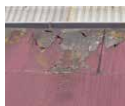
塗装(塗膜)は劣化する。塗り替えが必要
