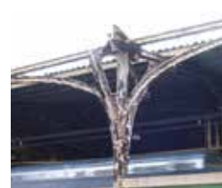
塗装(塗膜)は劣化する。塗り替えが必要
